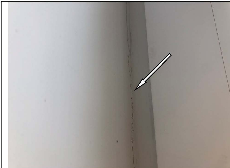
Фото №37. Трещина (щель) в месте примыкания оконного блока в кухне.
