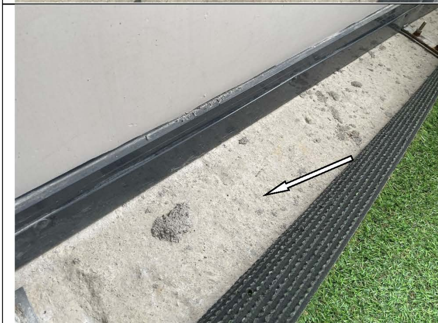
Фото №75. Железобетонные элементы конструкции (пол в лоджии 2) имеют дефекты (отсутствие однородности внешнего вида, трещины).
