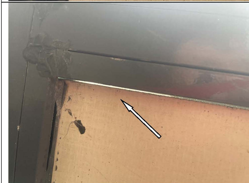
Фото №83. Отсутствует изоляция смежных конструкций (следы протечки) в лоджии 2.
