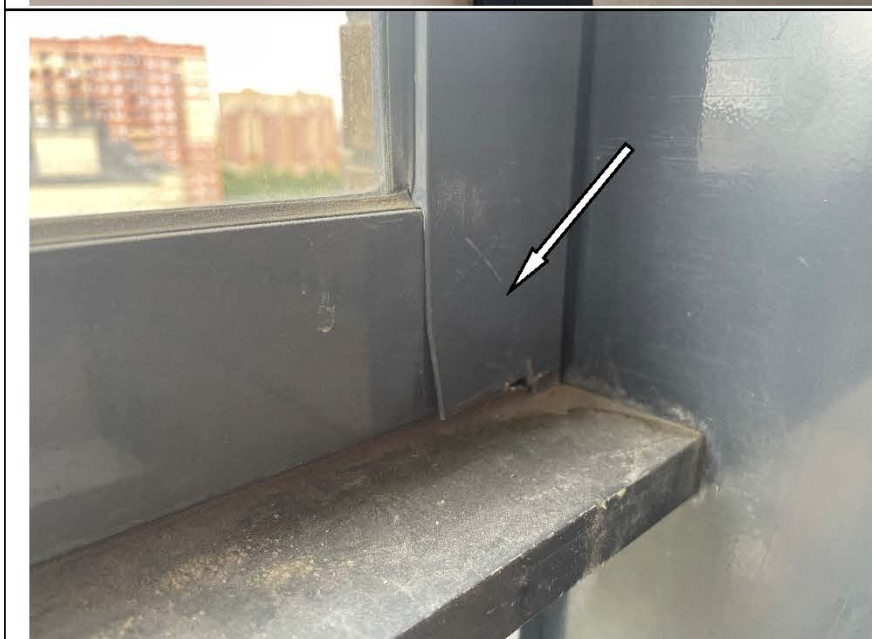
Фото №80. Дефект на металлическом профиле оконного блока (деформация) в лоджии 1.
