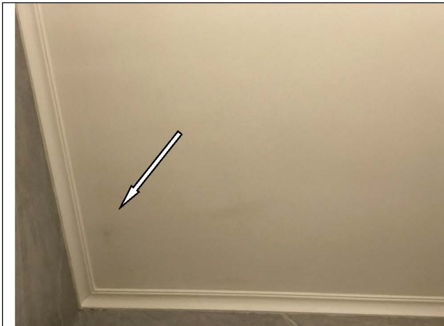
Фото №31. Окрашенный потолок в санузле выполнен с дефектами.
