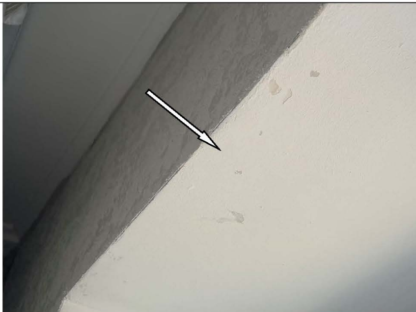
Фото №34. Окрашенные откосы оконного блока ПВХ в гостиной выполнены с дефектами.
