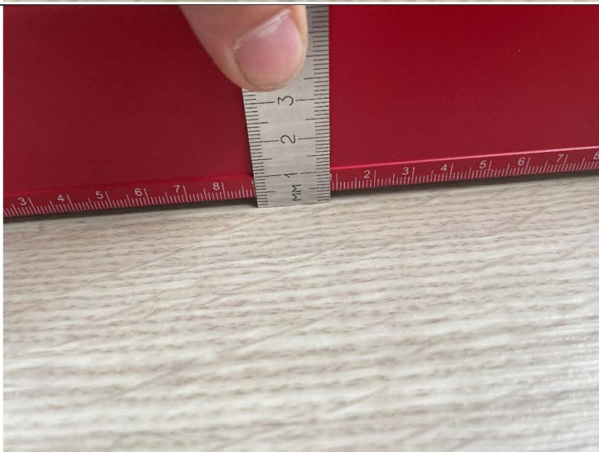
Фото №18. Измерение отклонения уровня пола в спальне.
