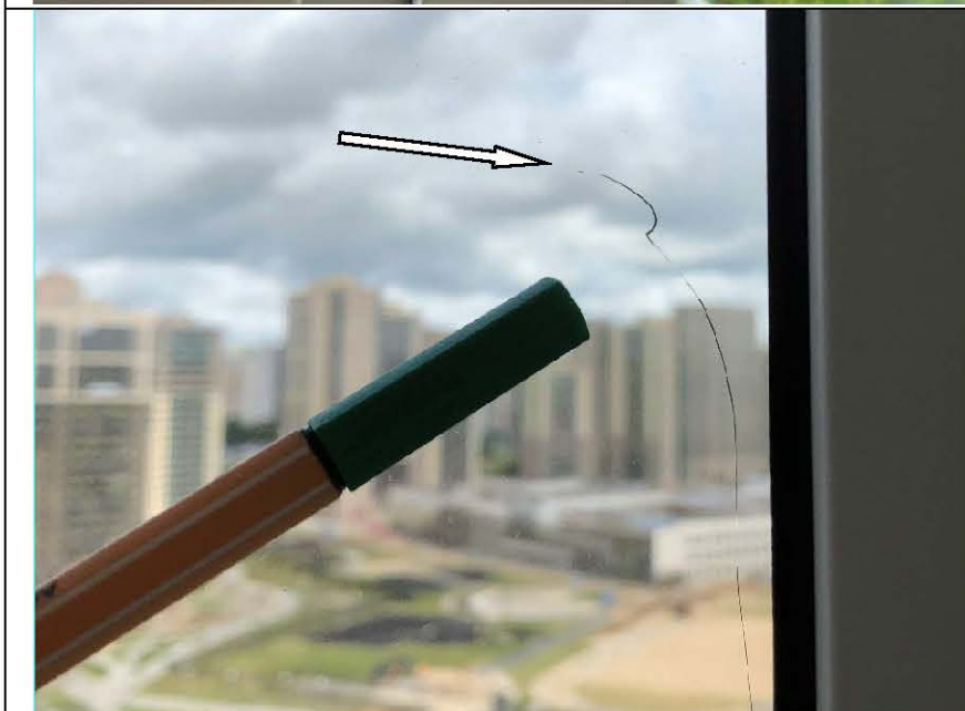
Фото №53. На стеклопакете оконного блока ПВХ в кухне, имеется дефект (царапина, окалины).
