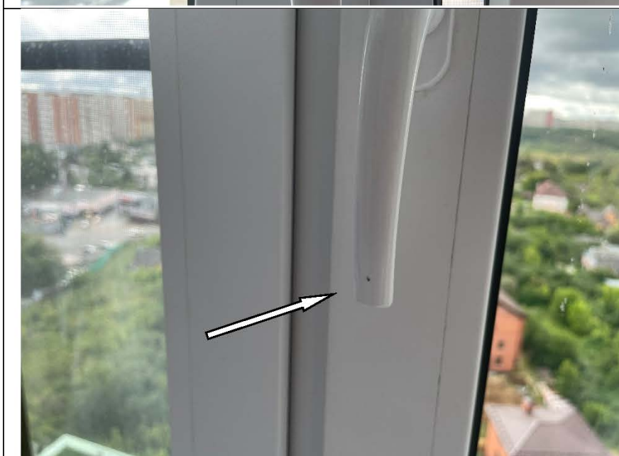
Фото №51. Царапины на фурнитуре оконного блока ПВХ в спальне (ручке).
