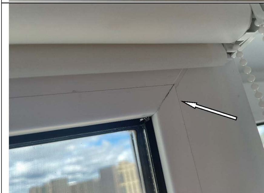
Фото №59. Профиль ПВХ оконного блока в гостиной имеет дефекты (царапины, загрязнения).
