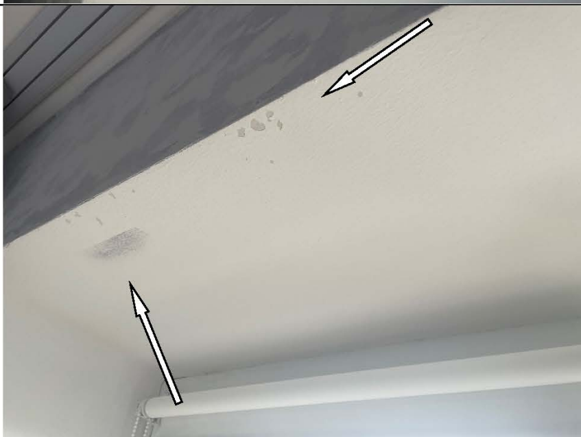
Фото №35. Окрашенные откосы оконного блока ПВХ в спальне выполнены с дефектами.
