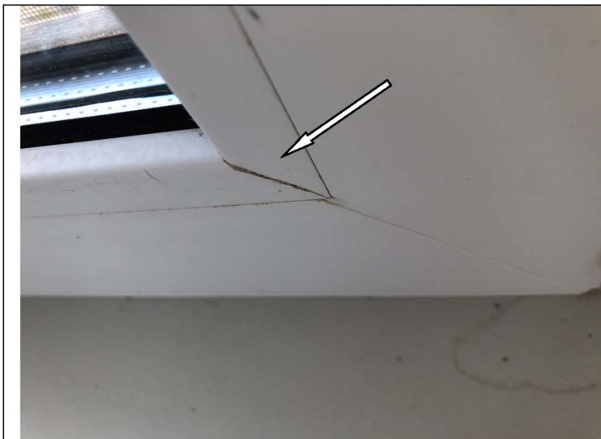
Фото №58. Профиль ПВХ оконного блока в кухне имеет дефекты (царапины, загрязнения).
