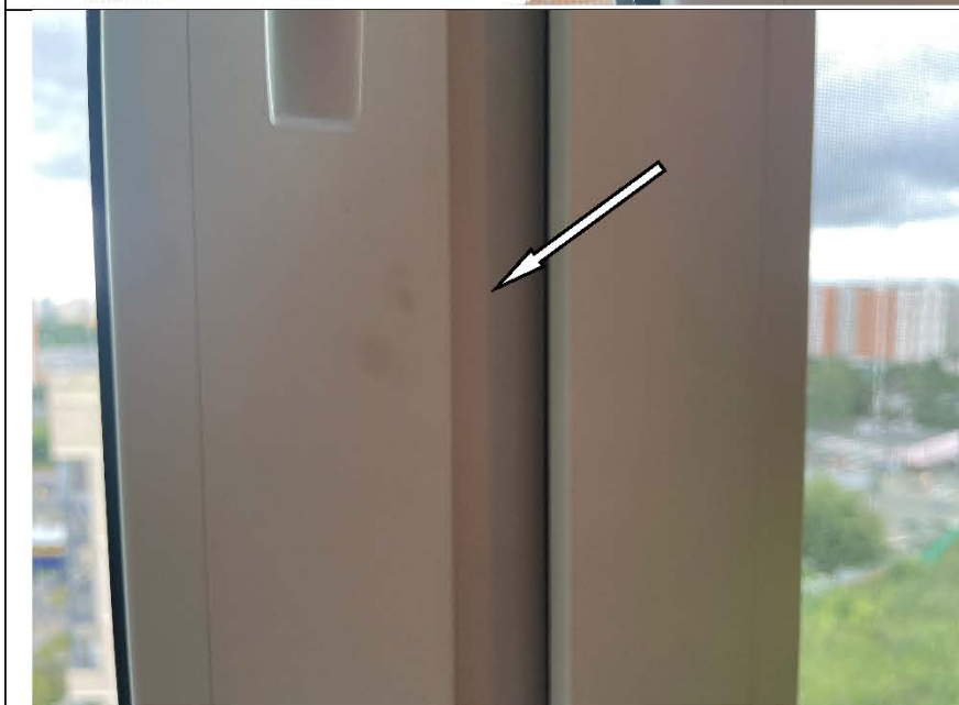
Фото №63. Профиль ПВХ оконного блока в детской имеет дефекты (царапины, загрязнения).
