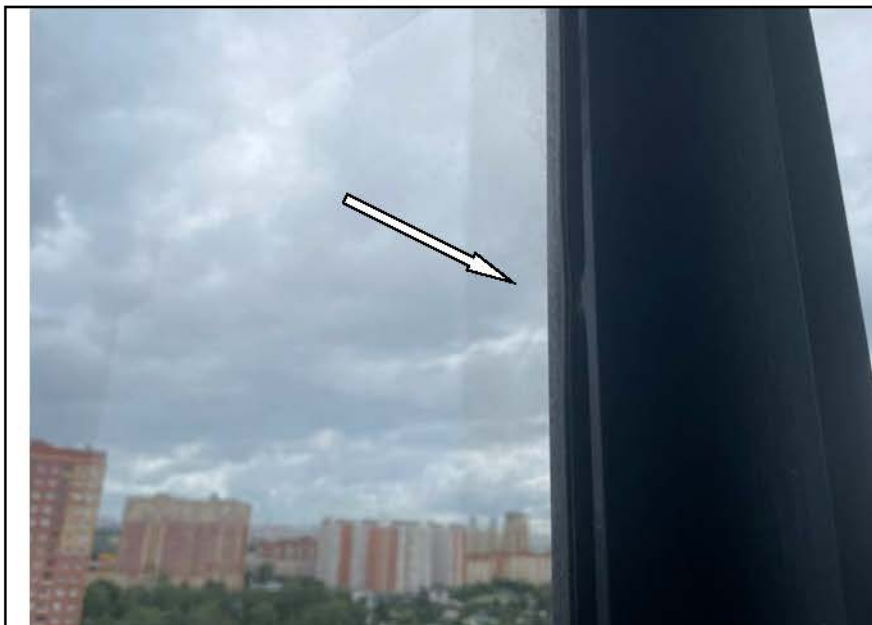
Фото №70. Дефект установки части уплотняющей прокладки на оконном блоке ПВХ в лоджии 2.
