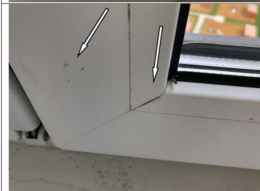
Фото №57. Профиль ПВХ оконного блока в кухне имеет дефекты (царапины, загрязнения).
