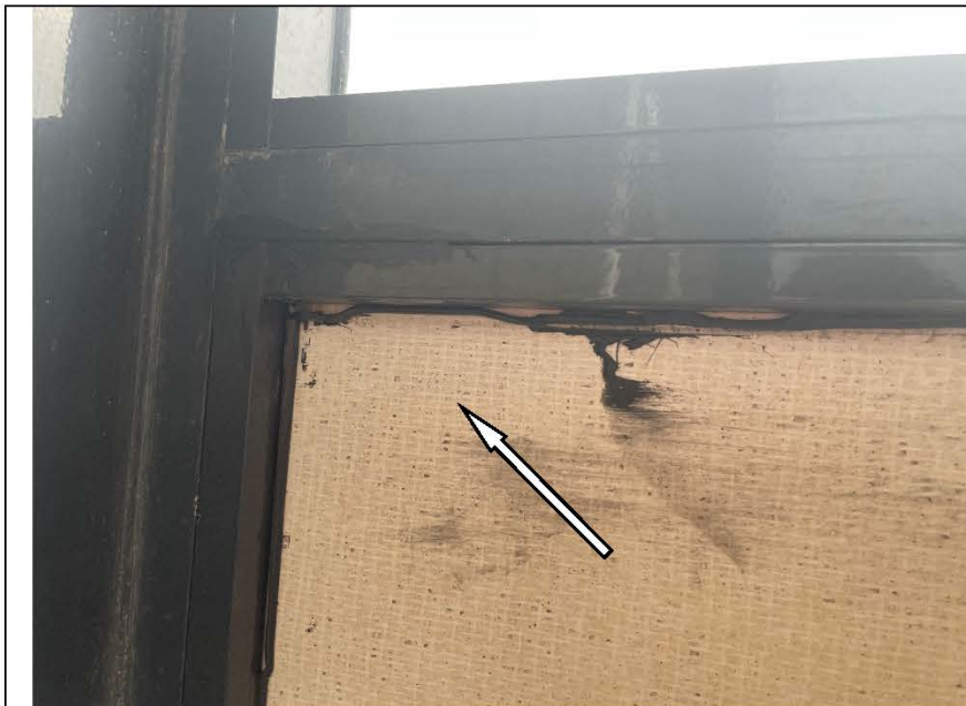
Фото №82. Отсутствует изоляция смежных конструкций (следы протечки) в лоджии 1.
