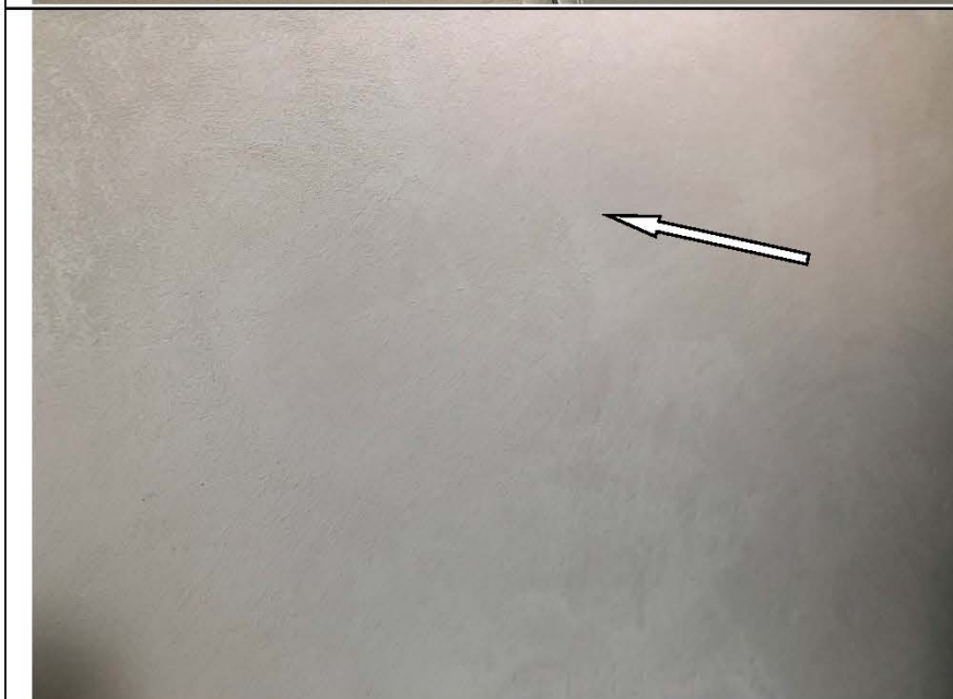
Фото №26. Оштукатуренные стены в кухне имеют дефекты (трещина).
