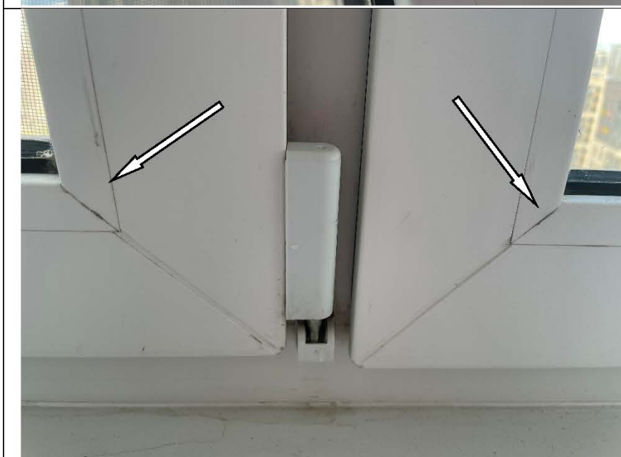
Фото №60. Профиль ПВХ оконного блока в гостиной имеет дефекты (царапины, загрязнения).
