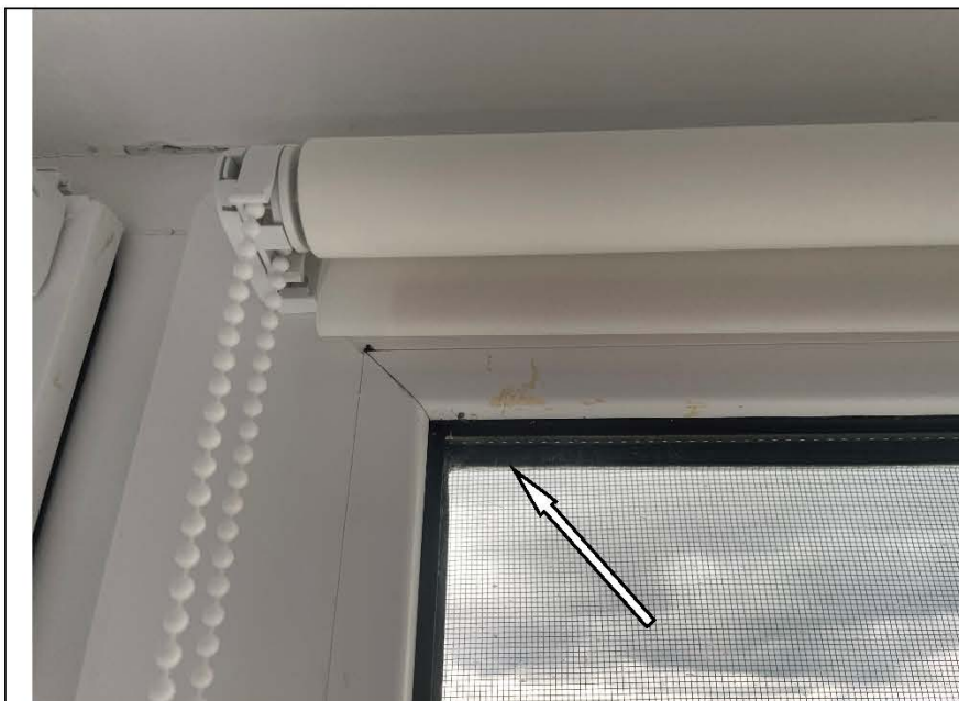
Фото №61. Профиль ПВХ оконного блока в спальне имеет дефекты (царапины, загрязнения).
