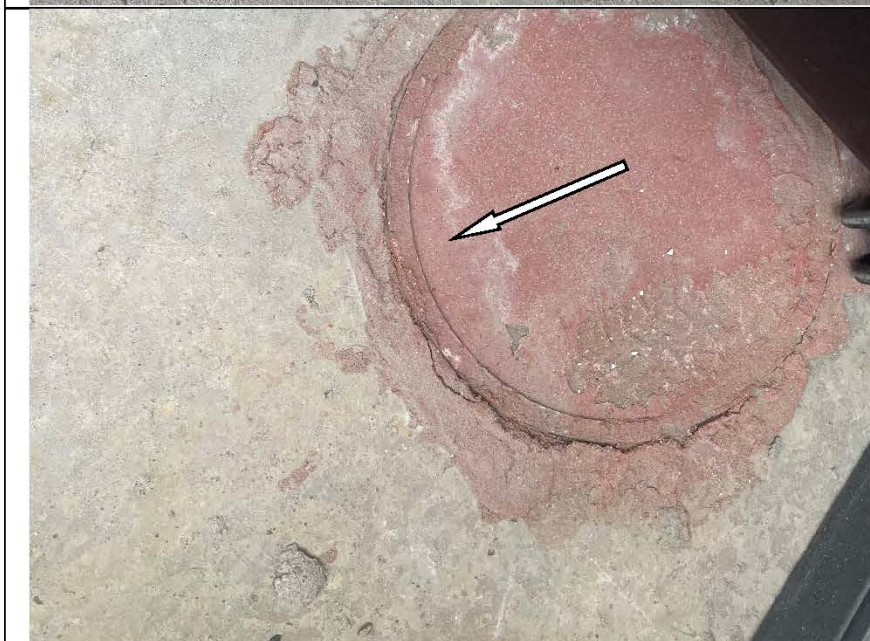
Фото №74. Железобетонные элементы конструкции (пол в лоджии 1) имеют дефекты (отсутствие однородности внешнего вида, трещины).
