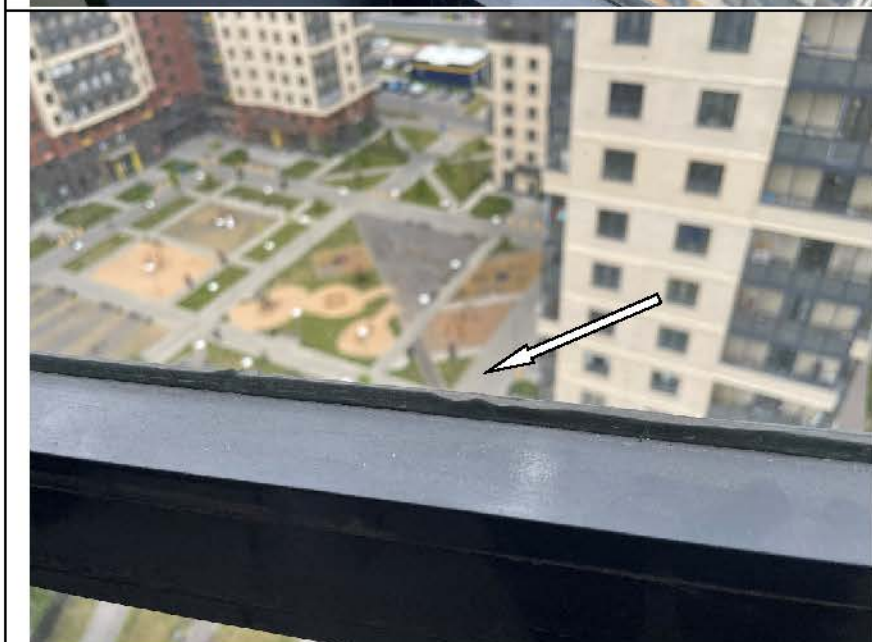
Фото №72. Дефект установки части уплотняющей прокладки на оконном блоке ПВХ в лоджии 1.
