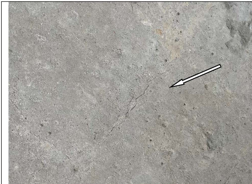
Фото №73. Железобетонные элементы конструкции (пол в лоджии 1) имеют дефекты (отсутствие однородности внешнего вида, трещины).
