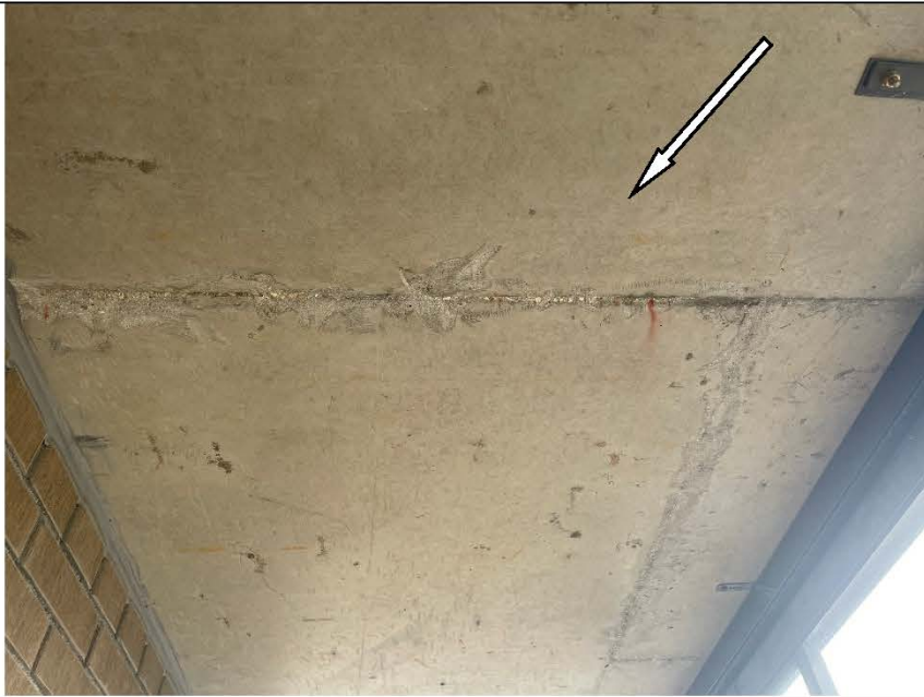
Фото №76. Железобетонные элементы конструкции (потолок в лоджии 1) имеют дефекты (отсутствие однородности внешнего вида, трещины).
