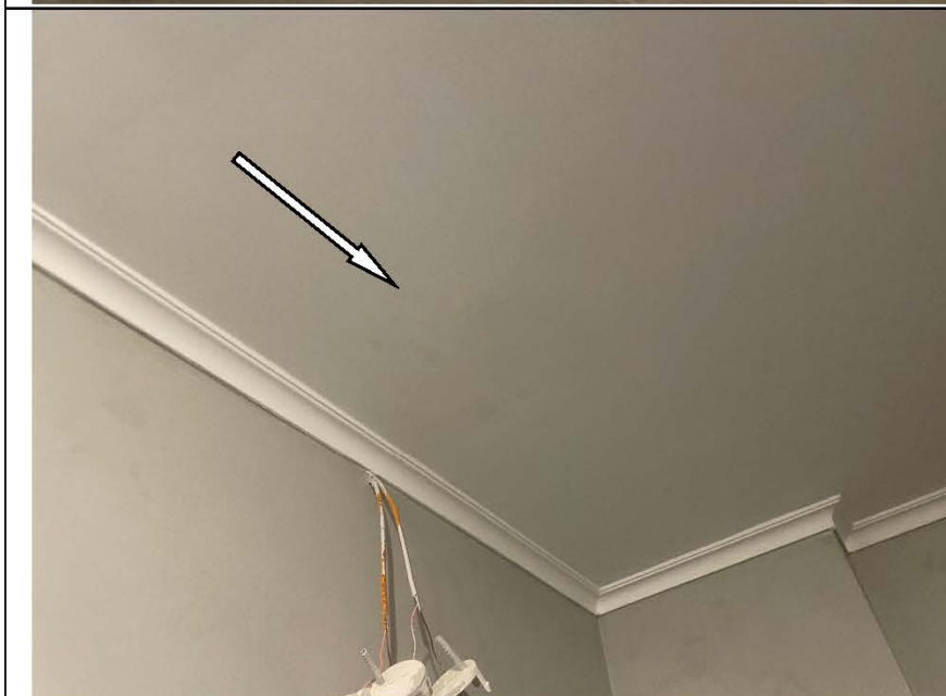
Фото №32. Окрашенный потолок в коридоре выполнен с дефектами.
