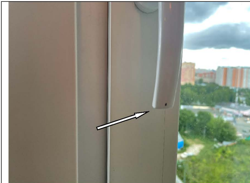
Фото №52. Царапины на фурнитуре оконного блока ПВХ в детской (ручке).
