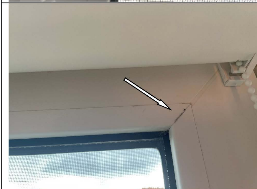
Фото №62. Профиль ПВХ оконного блока в детской имеет дефекты (царапины, загрязнения).
