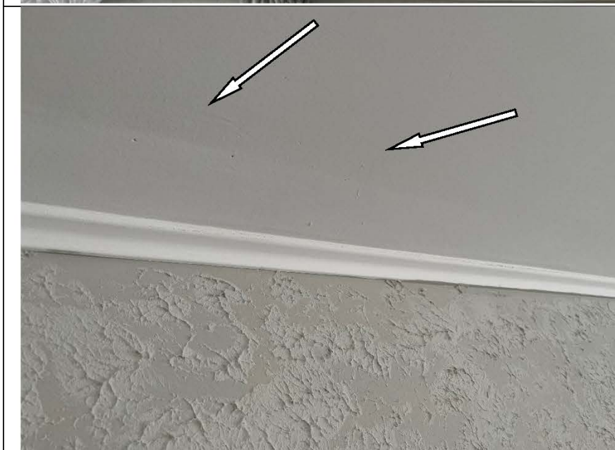
Фото №21. На оштукатуренном потолке в гостиной зафиксированы различные дефекты (полосы, раковины).
