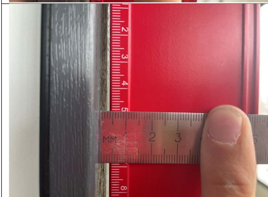
Фото №69. Отклонение профилей коробки ПВХ дверного блока в спальне.
