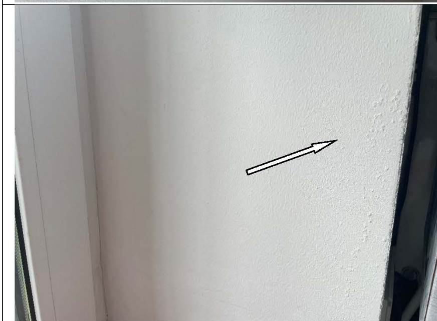
Фото №42. Окрашенные откосы дверного блока ПВХ в спальне выполнены с дефектами.
