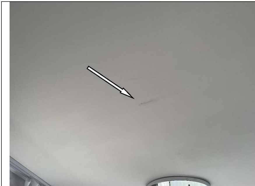
Фото №28. Окрашенный потолок в спальне выполнен с дефектами.
