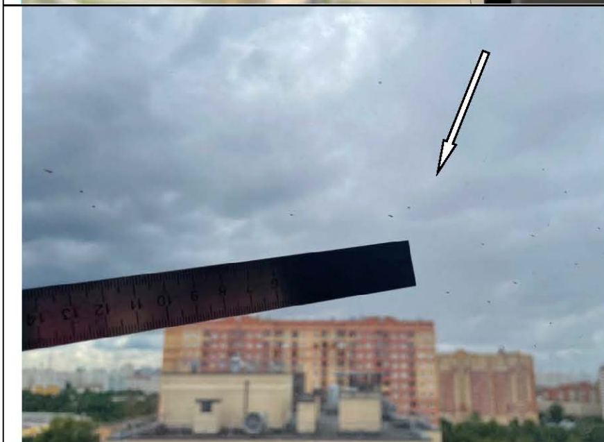
Фото №54. На стеклопакете оконного блока ПВХ в лоджии 1 имеется дефект (царапина, окалины).
