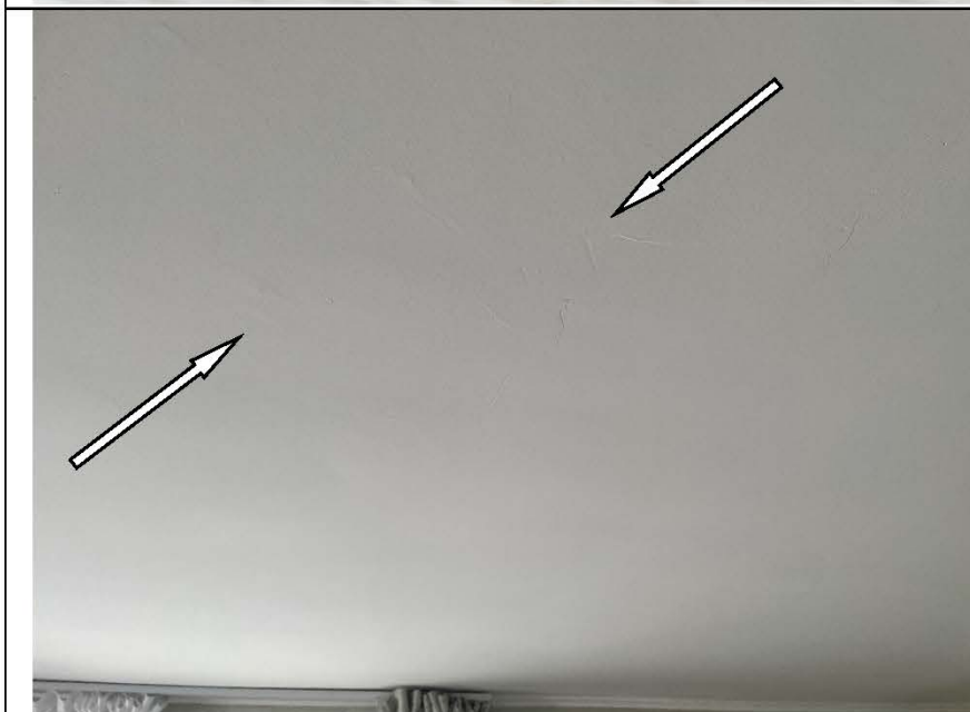
Фото №20. На оштукатуренном потолке в гостиной зафиксированы различные дефекты (полосы, раковины).
