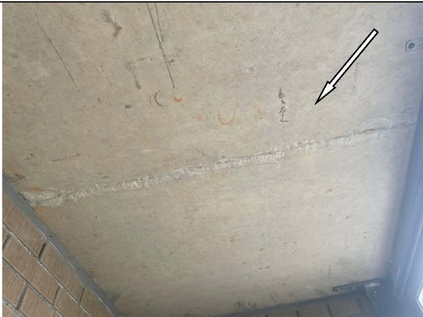
Фото №77. Железобетонные элементы конструкции (потолок в лоджии 2) имеют дефекты (отсутствие однородности внешнего вида, трещины).
