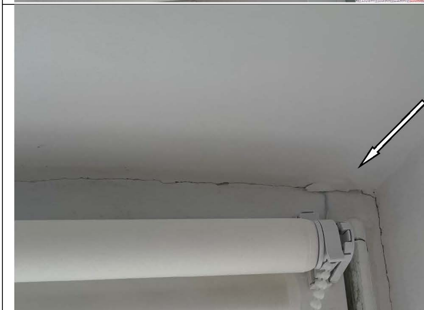
Фото №39. Трещина (щель) в месте примыкания оконного блока в спальне.
