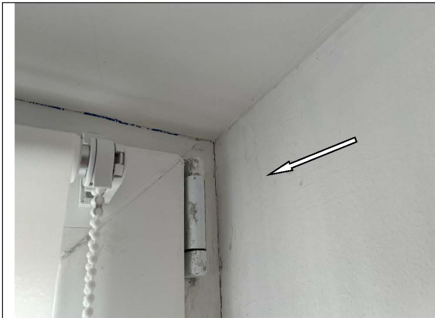
Фото №43. Трещина (щель) в месте примыкания дверного блока ПВХ в гостиной.
