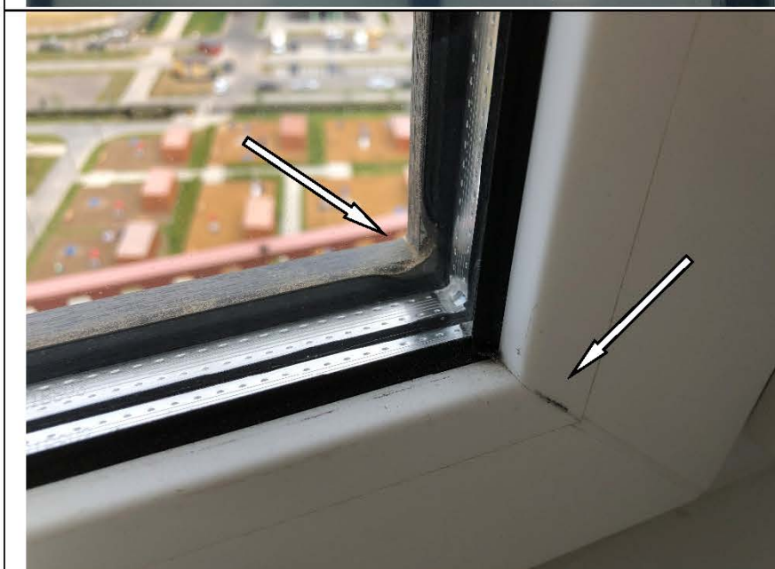
Фото №56. Профиль ПВХ оконного блока на кухне имеет дефекты (царапины, загрязнения), дефект установки части уплотняющей прокладки на оконном блоке ПВХ.
