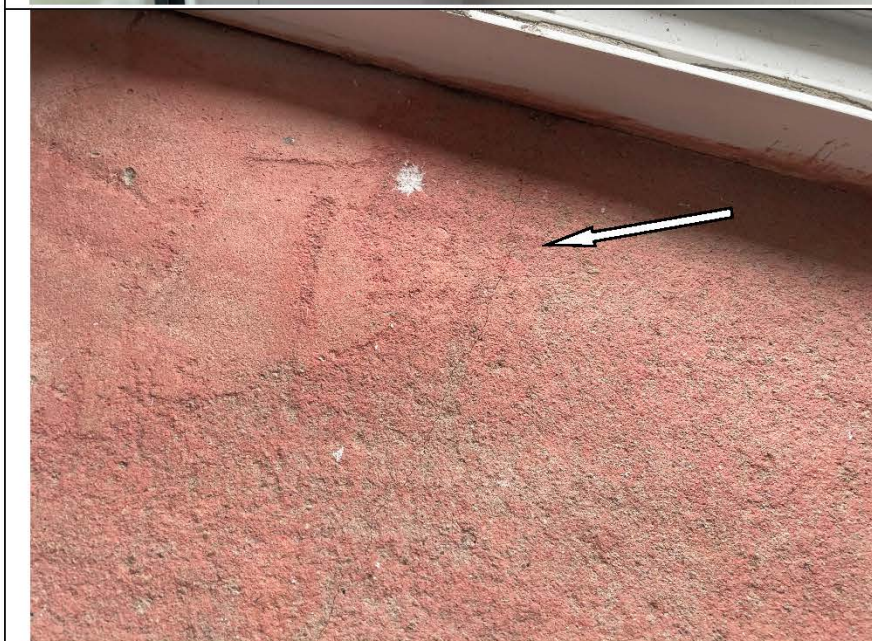
Фото №45. Железобетонные элементы конструкции (основание откоса дверного блока ПВХ в спальне) имеют дефекты (отсутствие однородности внешнего вида, трещины).
