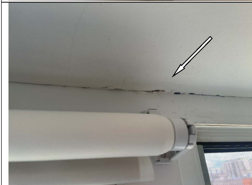
Фото №38. Трещина (щель) в месте примыкания оконного блока в гостиной.
