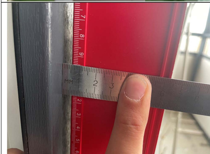
Фото №68. Отклонение профилей коробки ПВХ дверного блока в гостиной.
