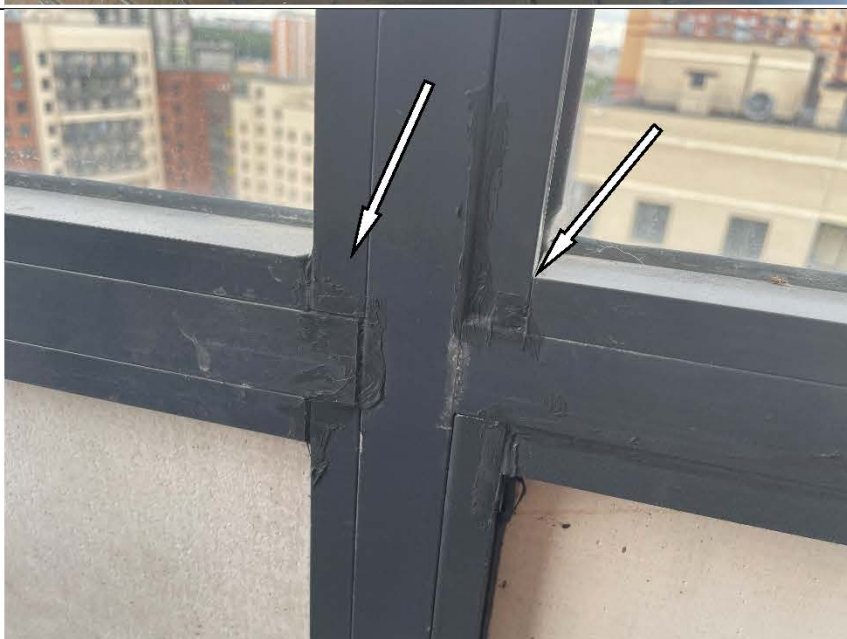
Фото №78. Дефект на металлическом профиле (зазор) оконного блока в лоджии 1.
