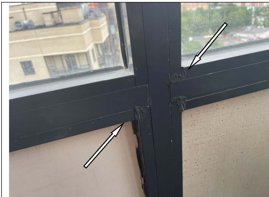
Фото №79. Дефект на металлическом профиле (зазор) оконного блока в лоджии 2.
