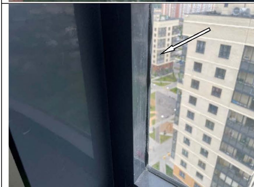
Фото №71. Дефект установки части уплотняющей прокладки на оконном блоке ПВХ в лоджии 1.
