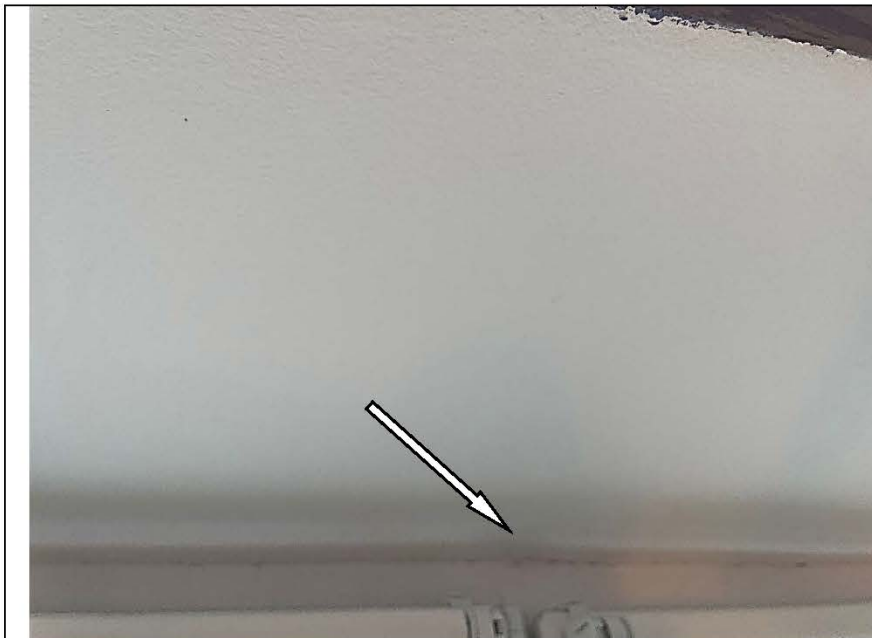
Фото №40. Трещина (щель) в месте примыкания оконного блока в детской.
