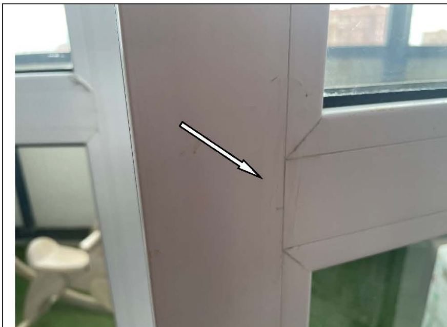
Фото №67. Профиль ПВХ дверного блока в спальне имеет дефекты (царапины, загрязнения, некачественная реставрация).
